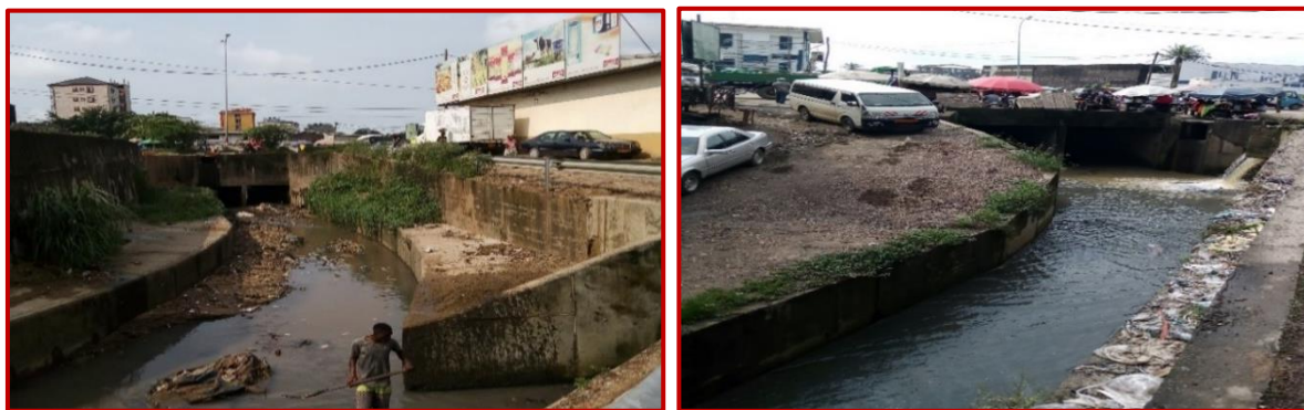
Photo 9 : (A) Drains aménagés respectivement sur le Tongo Bassa Cité SIC, et (B) sur le Mboppi au niveau de du quartier Mboppi.
