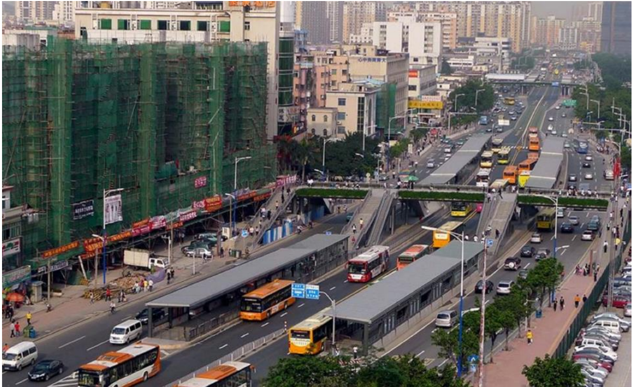
Une station BRT à deux sous-stations, avec passerelles piétonnes d'accès
