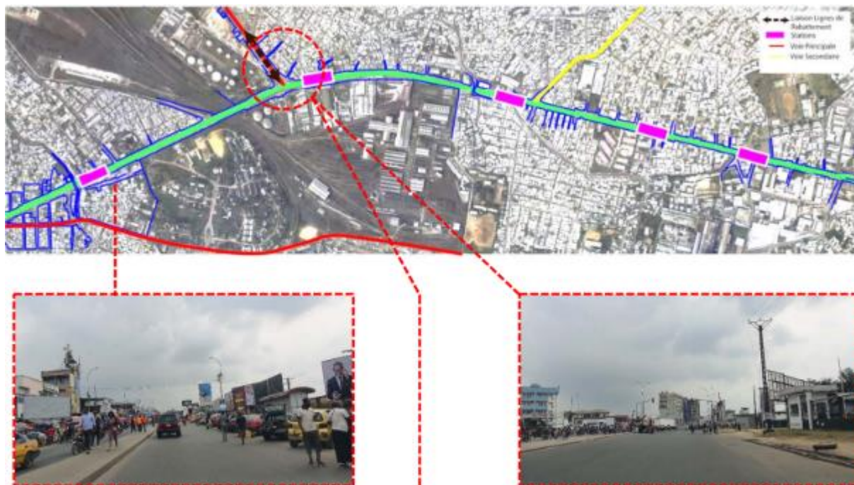
Figure 3 : Illustration de l'état actuel de la voie existante sur Camp Yabassi – Ndokoti
