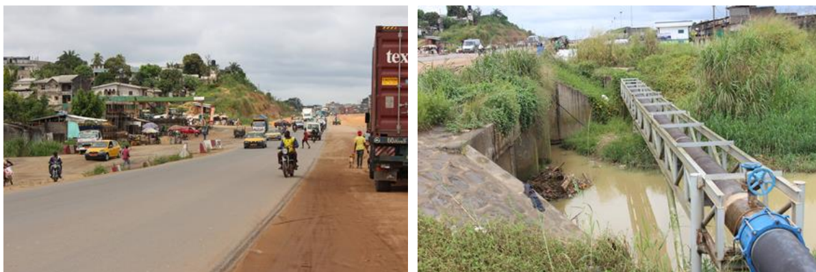
Types d'occupation du sol à la station de Grand tram sur la ligne BRT A3.
