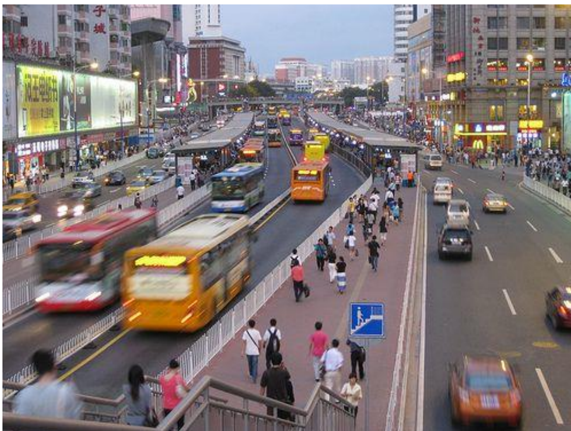
Photo 5; Vue des corridors piétons donnant accès aux stations depuis les passerelles piétonnes
